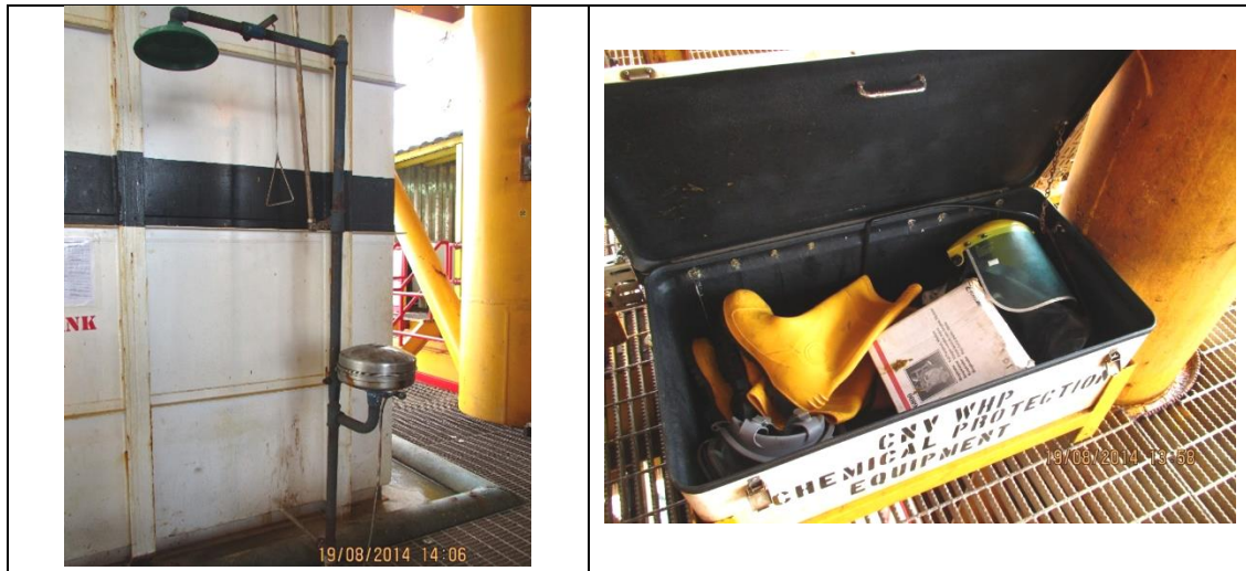
Hình 3.20 Các thiết bị ứng phó tràn đổ hóa chất được bố trí trên giàn
